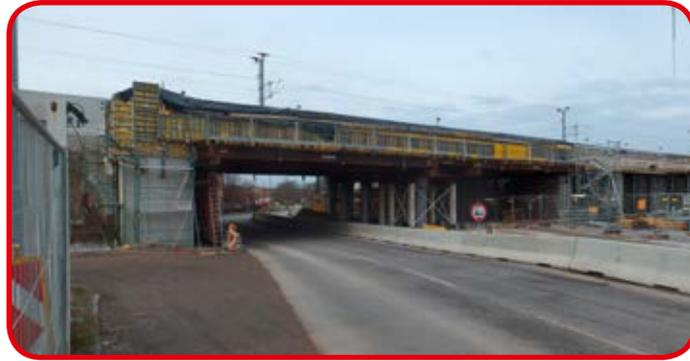
**Brückenbauwerk über Hauptstraße:** In den nächsten Wochen wird der östliche Teil des Brückenbauwerkes über die Hauptstraße fertiggestellt. Danach wird das Lehrgerüst abgebaut und im 2. Halbjahr 2018 die endgültige Fahrbahngestaltung hergestellt. Bis dato konnte ein längerfristiger Gegenverkehrsbereich mit Ampelschaltung vermieden werden, welcher ursprünglich im Raum stand.
